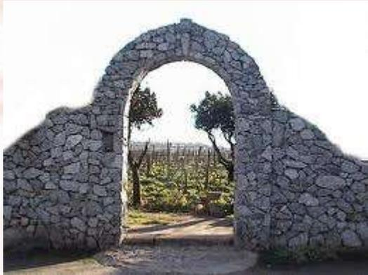
L'**arco**, in architettura, è un elemento strutturale a forma curva che si appoggia su due piedritti
