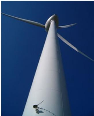
**Navicella:** contiene il riduttore e l'alternatore
