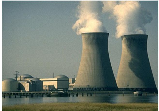
Il vapore arriva alla turbina, che è la stessa installata nelle centrali termoelettriche e utilizza il vapore ad alta pressione che va al condensatore per tornare allo stato liquido. Questo processo è a circuito chiuso perché il vapore dopo essere passato all'alternatore entra nel condensatore che lo fa ritrasformare in acqua e così via.
