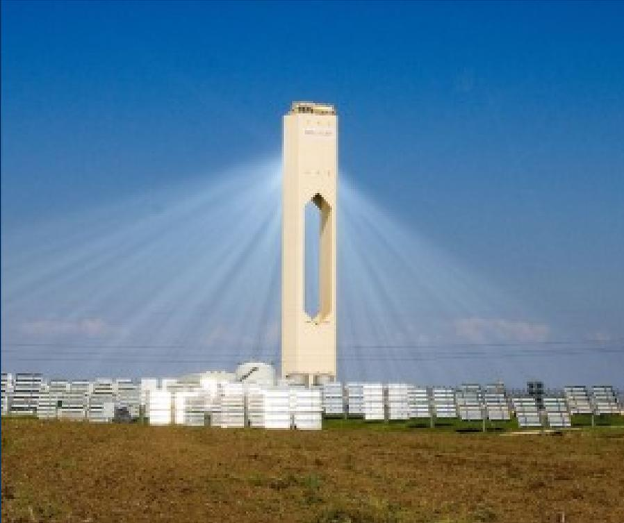
In questa caldaia, posta in cima a una torre, le altissime temperature dei raggi solari scaldano l'acqua, che diventa vapore.
