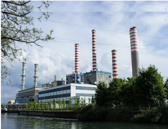
Centrale termoelettrica di Turbigo
