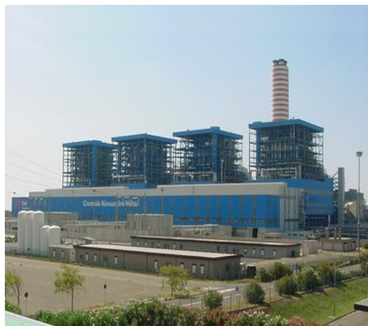
Centrale termoelettrica di Montalto di Castro
