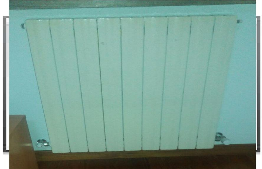
L' acqua, riscaldata dalla caldaia a 70°- 80°, va ai radiatori...
