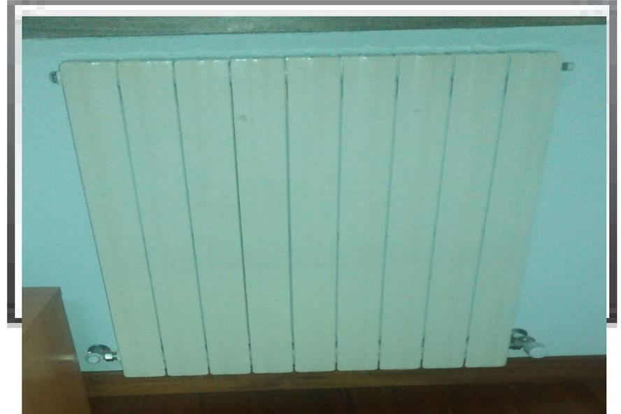
...dai radiatori, dopo aver riscaldato l'ambiente, l'acqua torna alla caldaia a 50°- 60° e il ciclo ricomincia.
